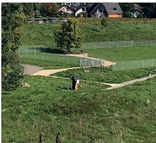
Travaux divers pour le nouveau « parc à chiens » (création d'un chemin, pose de bancs et poubelles)
