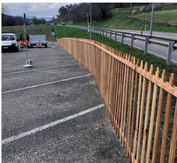
Clôture sur le parking des Île pour l'accueil des gens du voyage suisses
