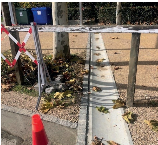
Réparations et remplacements au parking de la Plannaz
