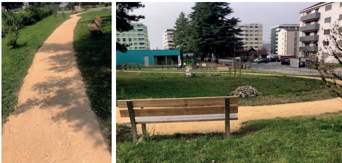
Projet de Parc à la Fondation Riant-Mont après travaux.
